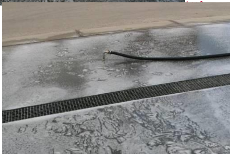
Foto: voorbeeld-aanbrengen Voorbeeld van luchtinbrengpunten luchtinbrengpunt.
